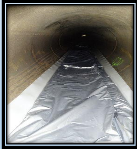
MALZEMENİN HATTA ÇEKİLMESİ
